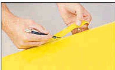
7.- Corte todo el exceso de material dejando entre 3 y 6 mm de solapado pegando firmemente todos los bordes, excepto la línea de ventilación si correspondiese.
